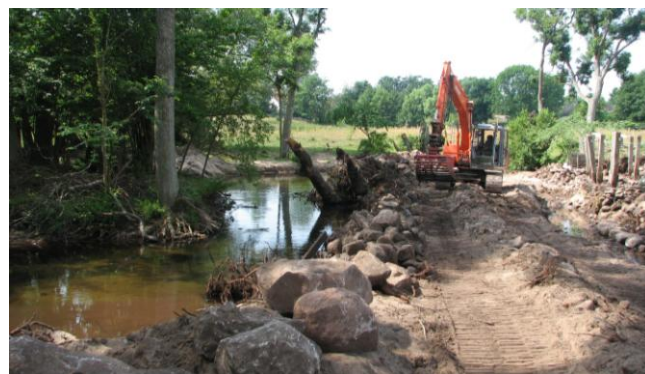
Grävmaskiner arbetade i flera månader.
